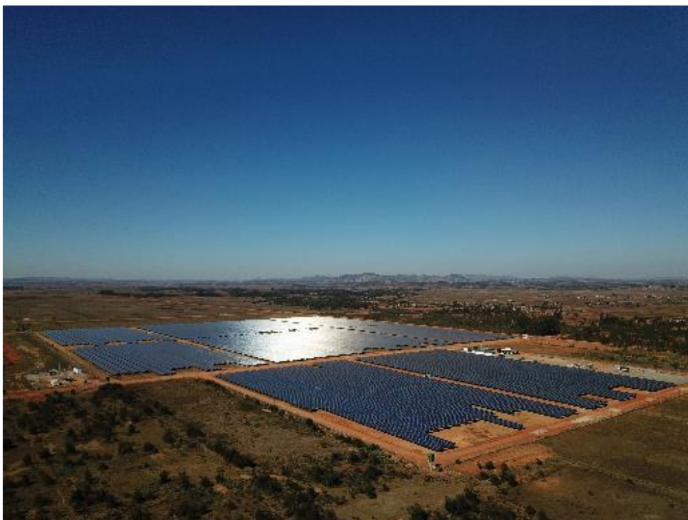
La plus grande centrale solaire au sol malgache d'Ambatolampy, construite par GreenYellow (20 MWp)
